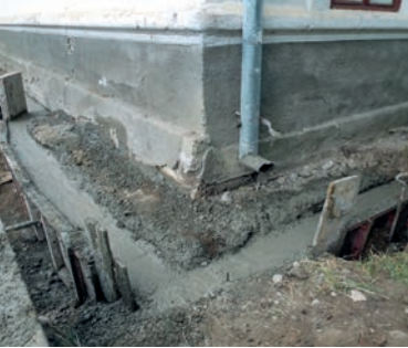
Az Óvoda fundamentumának megerősítése
