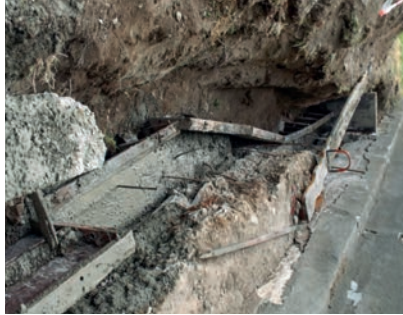
Az Óvoda fundamentumának megerősítése
